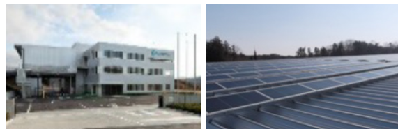
小川ロジスティクスセンター／太陽光発電システム
