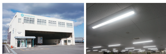
羽山ロジスティクスセンター／LED照明
