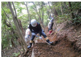
傾斜地を歩きやすく整地し、間伐材を土留めとして活用
